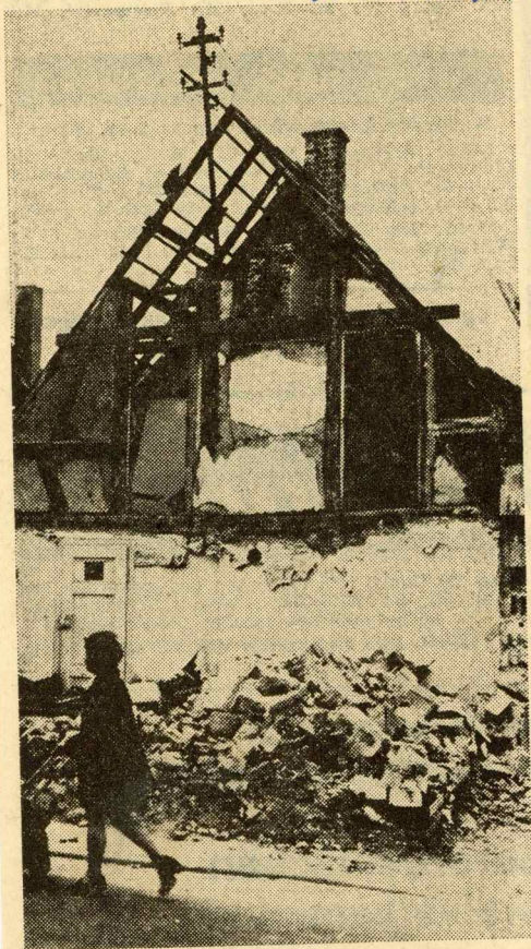
MIT DEM ABRISS eines der bei dem schweren Verkehrsunfall in Nackenheim im vergangenen Jahr demolierten Häuser, ist jetzt begonnen worden. Foto: Klos
